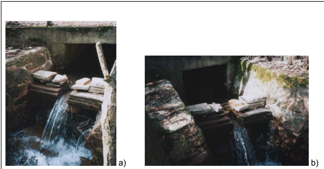
Abb. 11: Messstelle MP 2a, Steinbach mit einem natürlichen Überlauf
